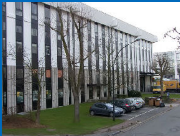
Vue extérieure de notre site de Rungis
