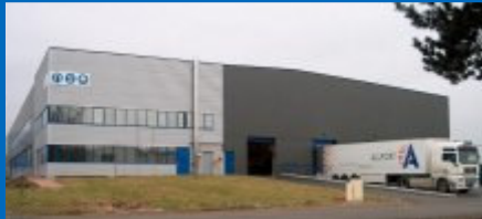
Un des bâtiments logistique de NSE Vichy
